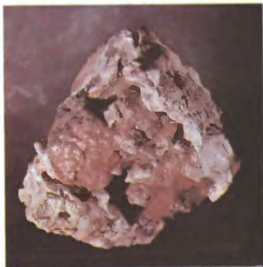
Разъединение шамотного пода стекловарной печи.
